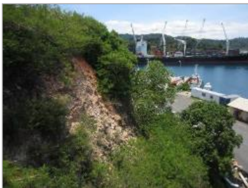
Talus amont, faciès d'érosion marqués
